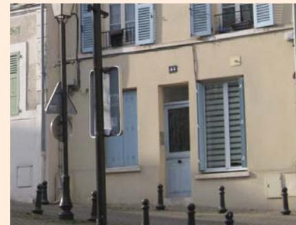
MENUISERIES : 44 rue de Paris et 23 rue de Saint-Germain : dégradation progressive des menuiseries. Le remplacement des menuiseries d'origine par des menuiseries bois entraîne dans un premier temps la disparition des petits bois. Dans un second temps, remplacement des menuiseries bois par du PVC.
