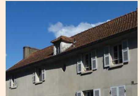
COUVERTURE : 29 rue Saint-Germain, Remplacement de la tuile plate par de la tuile mécanique
